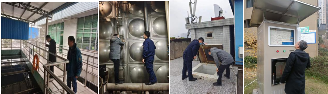
检查集中式供水水池
